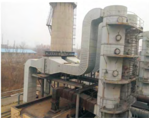
图 3 改造后现场 Fig. 3 The scene after modification
