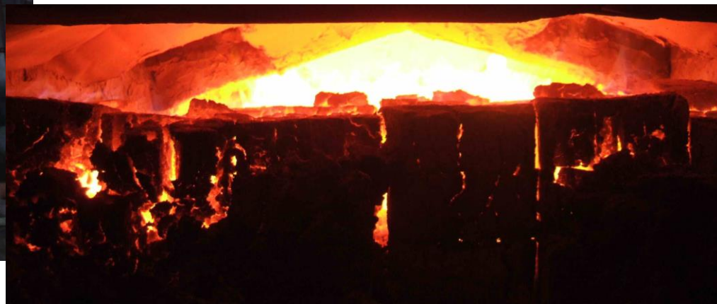
从炉排后部观察的商品型煤燃尽状态
