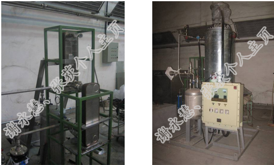
图 3.8 有机工质回热发电系统
